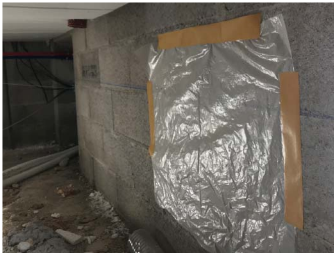
Figure 3 : Protection des orifices de ventilation
